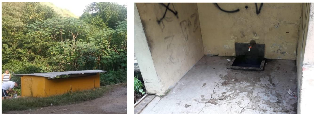
Figura 10: Construção de alvenaria feita por moradores para uma mina d'água no início da trilha para a pedreira.
